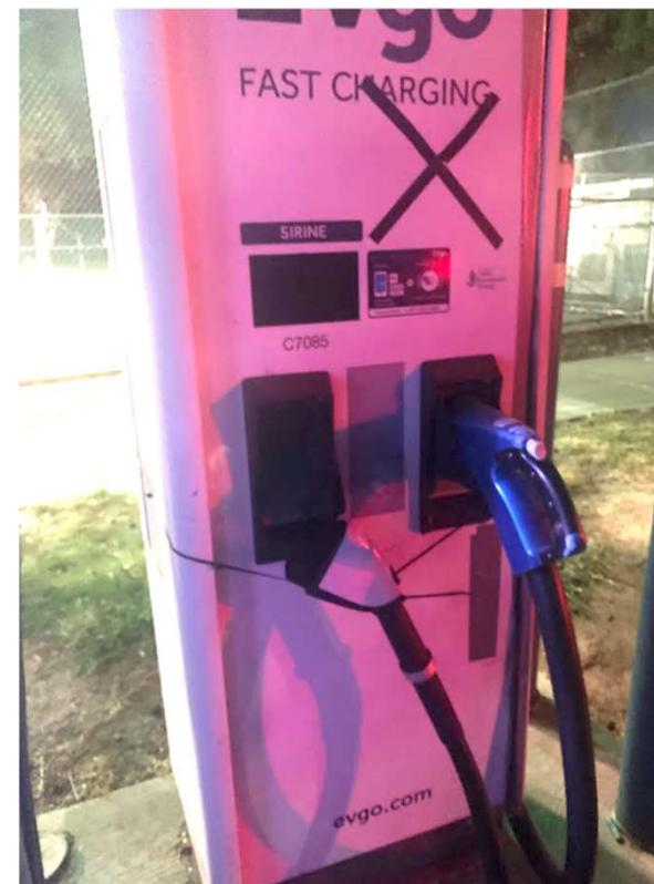
故障原因はコネクタ破損、本体機器故障、通信障害など様々
