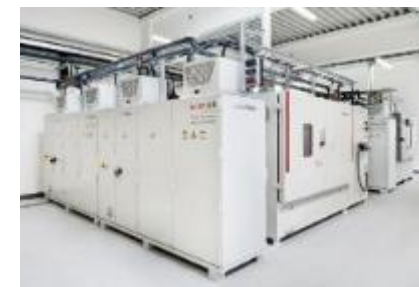
バッテリー試験システム
