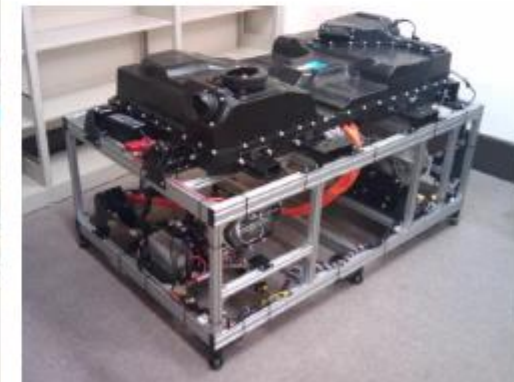
リユース蓄電池
