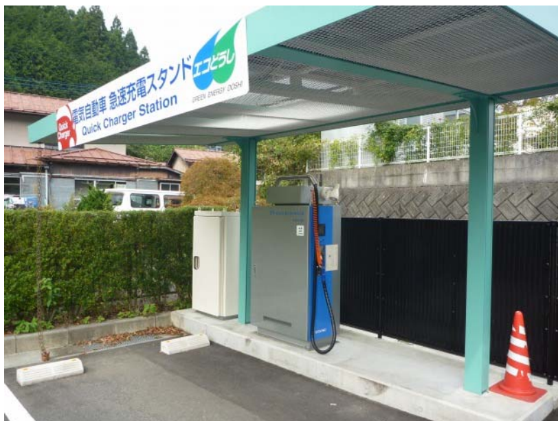
事例：山梨県道志村「道の駅 どうし」
