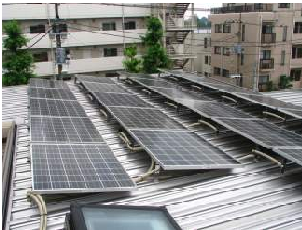
太陽電池モジュールは22枚 7直列に接続されたストリングが2系統 8直列に接続されたストリングが1系統
