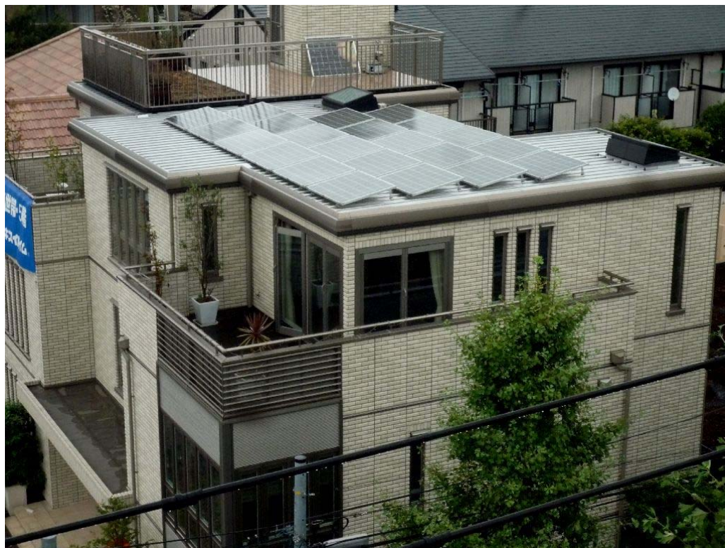
3階建ての一般住宅の屋上テラスに太陽電池モジュールが設置されている(地上約7m)
