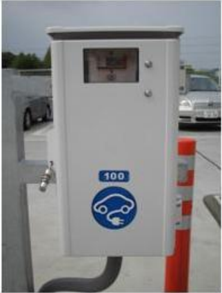
壁掛コンセントBOX
