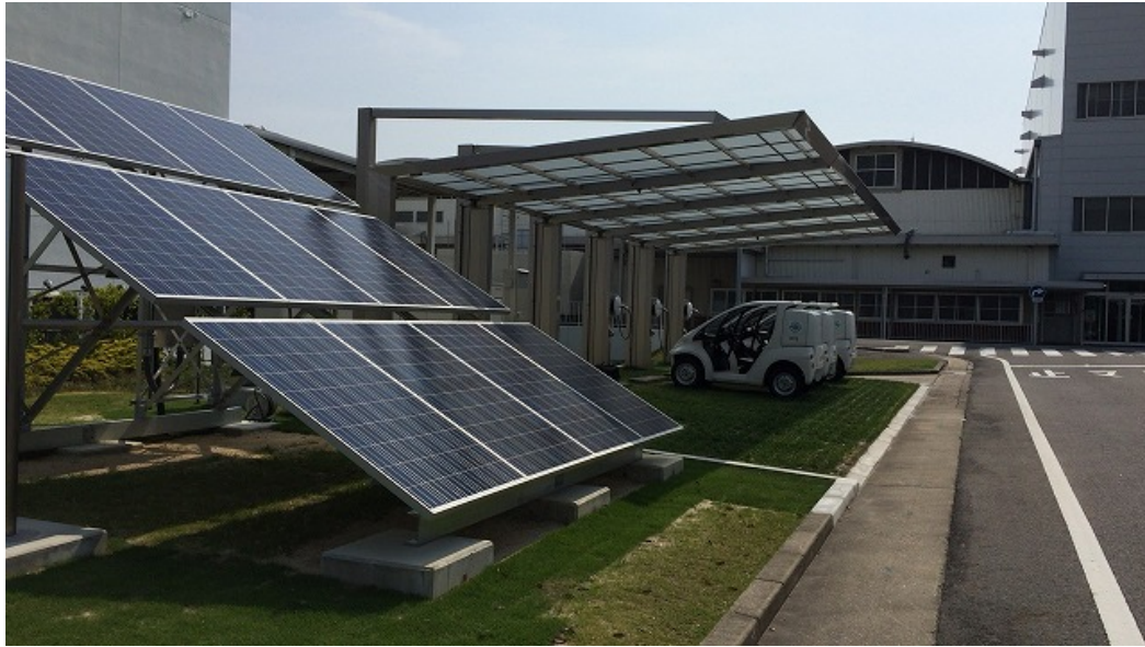
安城製作所の事務棟前に設置されたピコグリッドシステム
