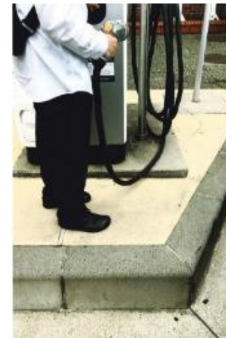
段差による転倒リスク
