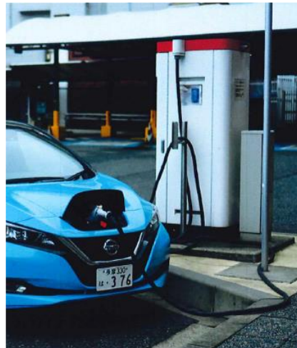
ケーブル引き回しによる美観悪化
