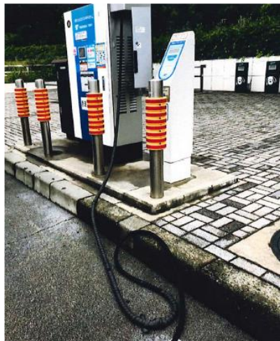
ケーブルが重く、引きずる負担 ポールにより車両ドア開閉困難
