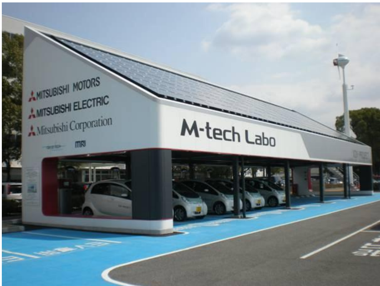
スマートグリッド実証試験装置「M-tech Labo」
