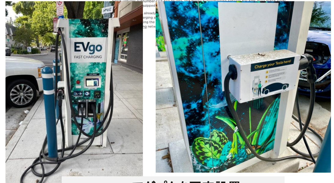
Teslaアダプタを固定設置
