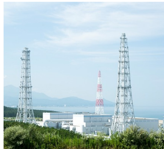
原子力発電設備
