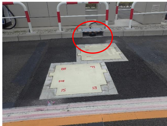
地上コイル脇に地面すれすれに設置されたレーザーセンサー
