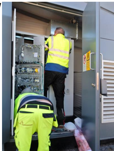
電源装置建屋内部
