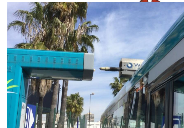
充電コネクション状況
