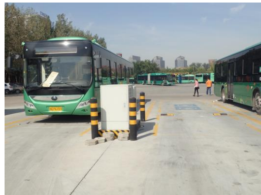
120kW電源盤と冷却システムが5基設置、1基の電源から交互に2台のバスに充電
