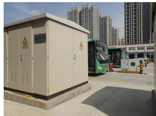
12kV/630kVAの高圧変電盤、電池の搭載状況と無線充電のエンブレム
