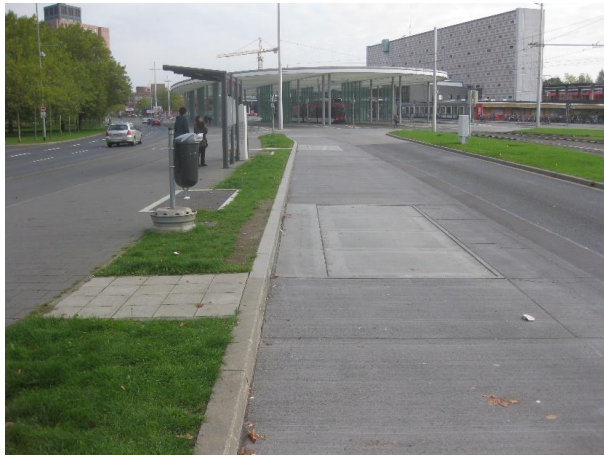
ターミナルの2台の地上コイル バス停専用道路の地上コイル
