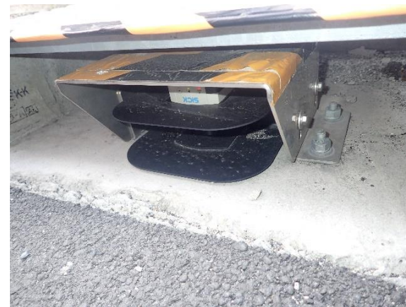
地上コイル脇に地面すれすれに設置されたレーザーセンサー
