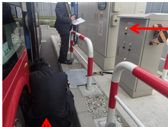
地上コイル脇に地面すれすれに設置されたレーザーセンサー
