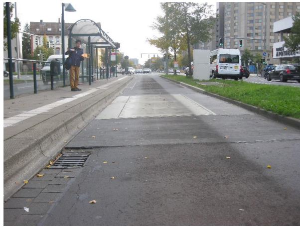
ターミナルの2台の地上コイル バス停専用道路の地上コイル
