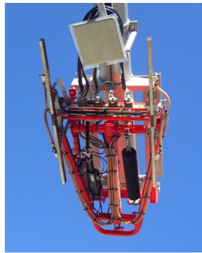
カバーのないパンタ部
