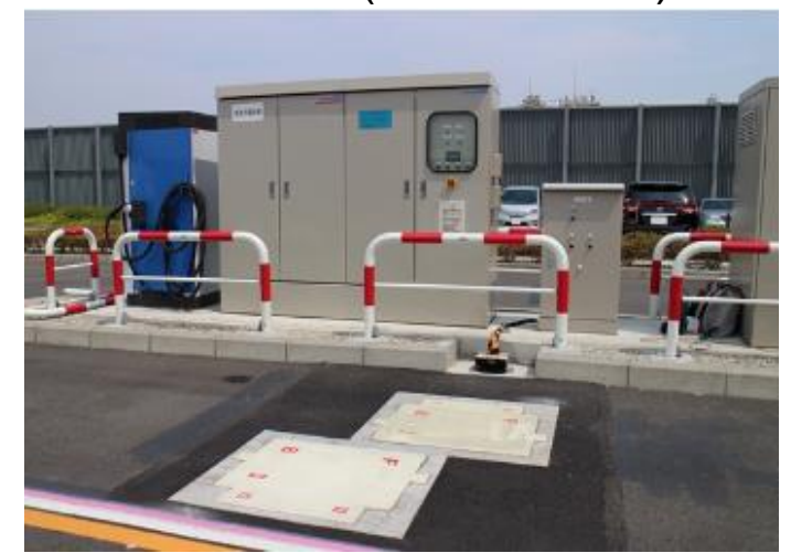
1次コイルの設置状況
