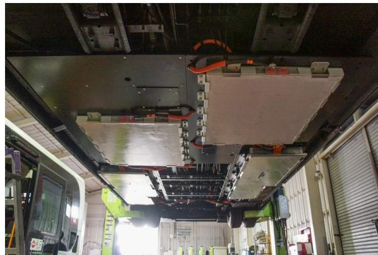
2次コイルの設置状況
