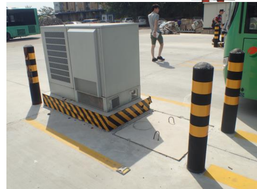
120kW電源盤と冷却システムが5基設置、1基の電源から交互に2台のバスに充電
