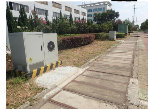
車両外観、各2基の120kW電源盤と冷却システム、奥の高圧電源(160kVA)
