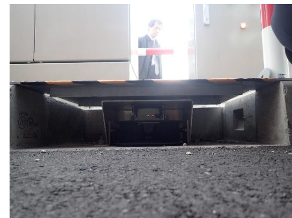
地上コイル脇に地面すれすれに設置されたレーザーセンサー
