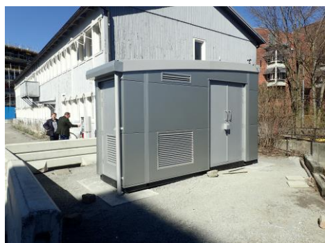
電源装置建屋
